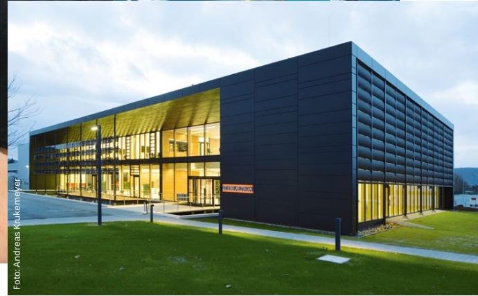
▲ Energy Campus: Das Ende 2015 eingeweihte Schulungs- und Kommunikationszentrum von Stiebel Eltron ist mit seiner Haustechnik ein echtes Reallabor für die Energiewende und bietet modernste Präsentationsmöglichkeiten.
